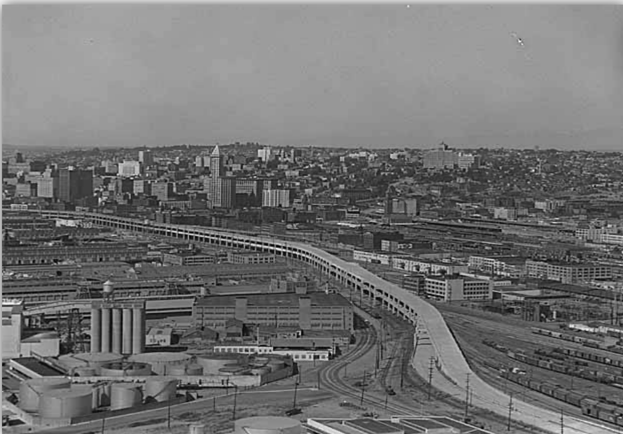
Imagen tomada de https://digitalcollections.lib.washington.edu/digital/collection/imlsmohai/id/2135/rec/1 Vista aérea del viaducto Alaskan Way con vista al noreste hacia Seattle, 1959.
